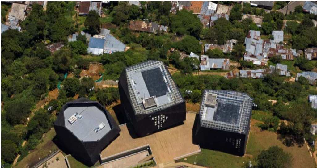
Imagen 3. Biblioteca España en comuna 13, aquí se puede observar el contexto que fue impactado a través de la estética del edificio transformando este segmento en la comuna en ambientes educativos. Foto: Sergio Gómez, Diana Moreno, Carlos Tobon en Archdaily.
