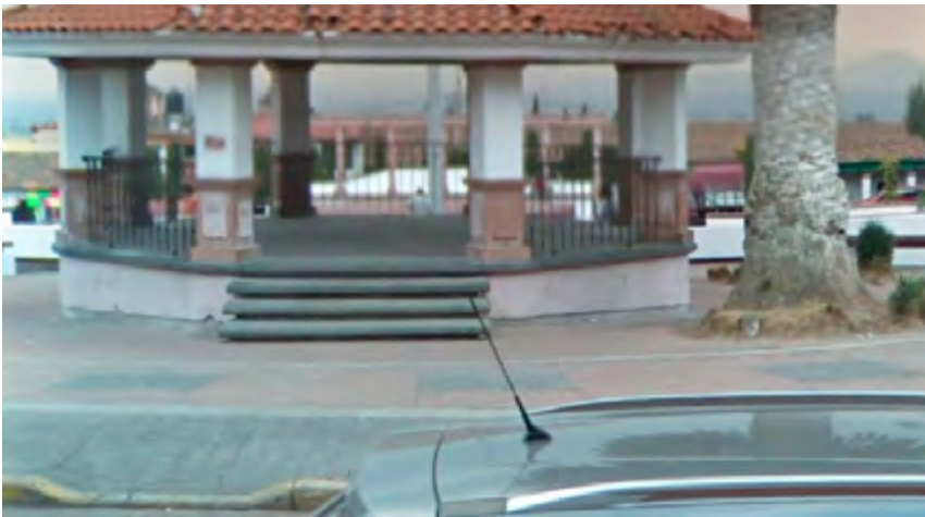
Imagen 5. Escaleras sin barandales ni rampas (González, 2022)
