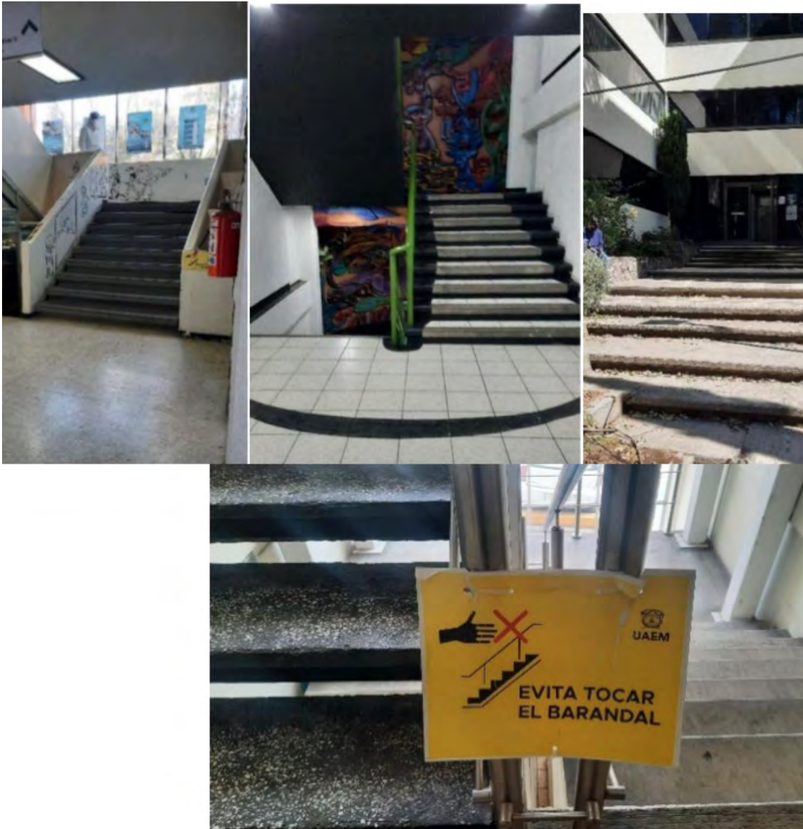
Figura 13 Barandales en los edificios
