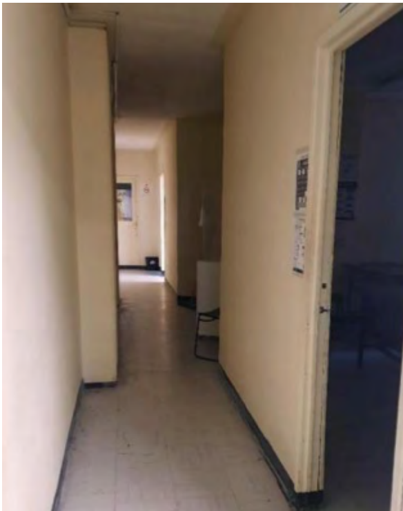
Figura 24 Iluminación natural en los pasillos
