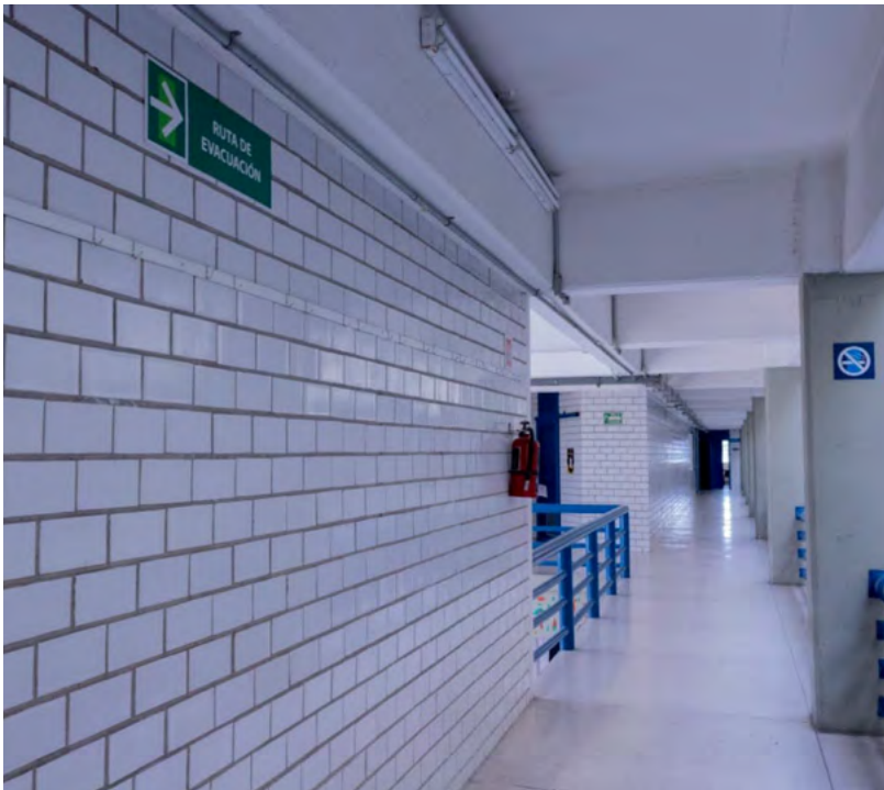
Figura 6. Pasillo del Edificio de Diseño. FES Cuautitlán.
