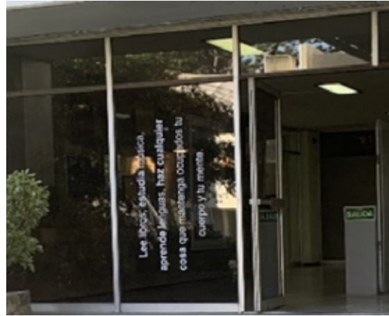
Imagen 9. Señalética no accesible por su disposición vertical (Solano, 2022)
