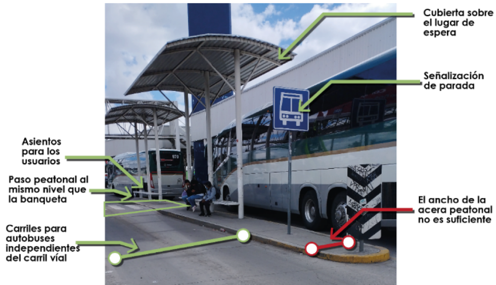
Figura 7 Infraestructura encontrada en paradas Tipo A
